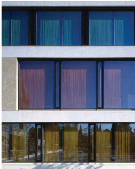
Zentrum Leue, CH-Männedorf · Stücheli Architekten, CH-Zürich
